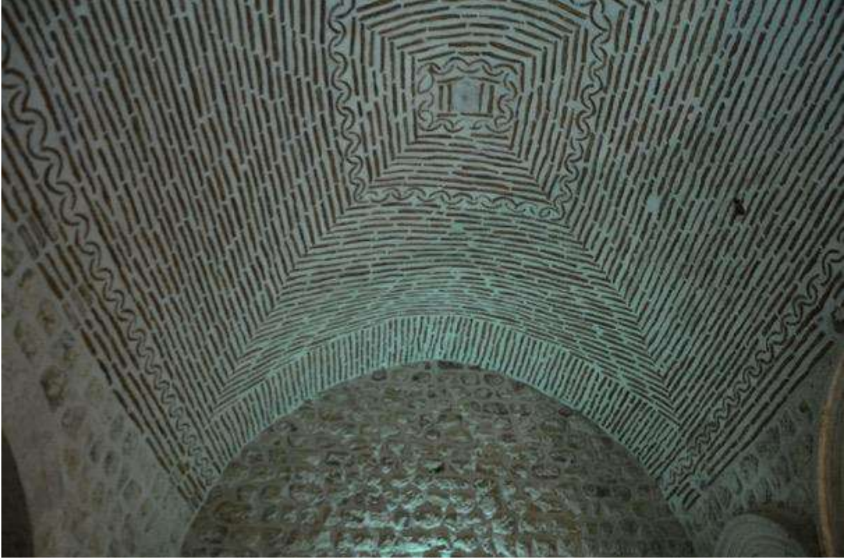
Fotoğraf 24: Mor Yuhannon Kilisesi Mezbahı Tuğla Malzeme Kullanılan Çapraz Tonoz Üst Örtüsü
