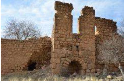
Fotoğraf 7: Mor Abay Manastırı Dođu Cephesi
